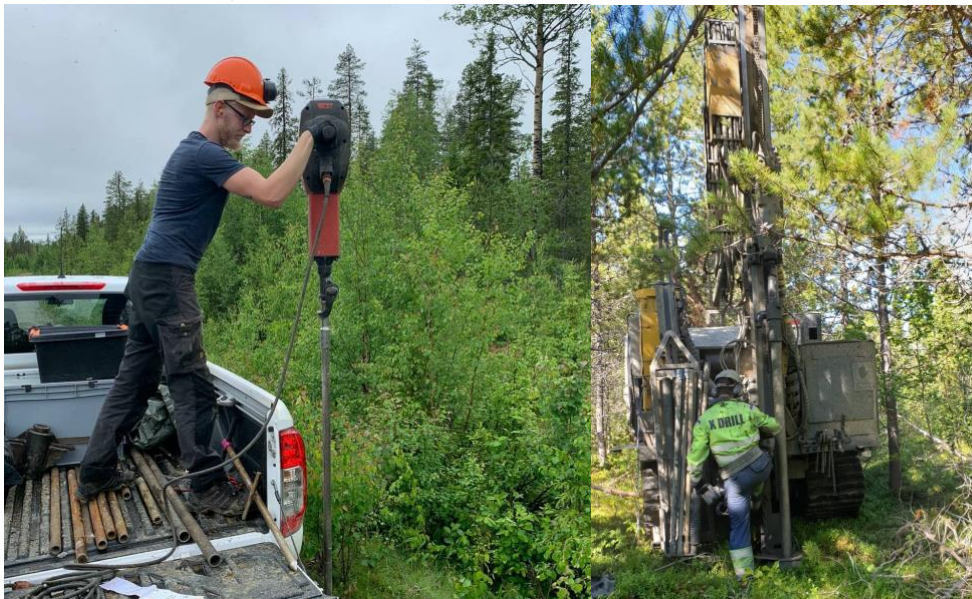
Abbildung 3: HILTI-Drilling (links) und BoT-Drilling (rechts).
